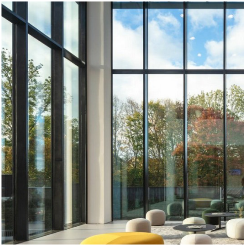
Pfosten-und Riegel- Fassade
