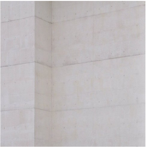
Wandflächen in Sichtbeton Beimischung von 3% Weißpigmenten
